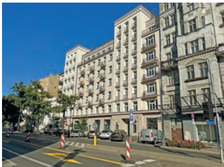
Domy przy al. Szucha 4-6, pod którymi rozegrały się sceny walki po ewakuacji z domu nr 8. Fot. M. Olczak, 2023 r.
