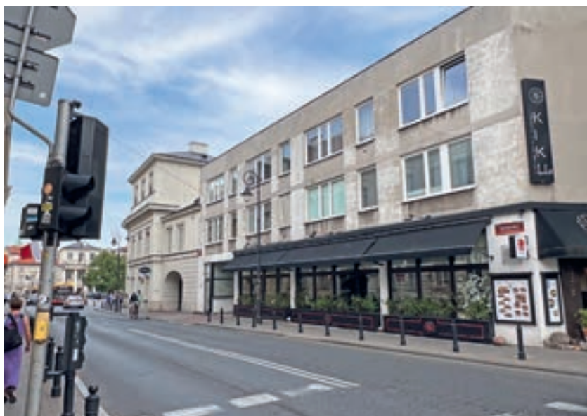
Miejsce akcji – ul. Senatorska 17 – widok od strony pl. Teatralnego. Fot. R. Kierzkowski, 2024 r.
