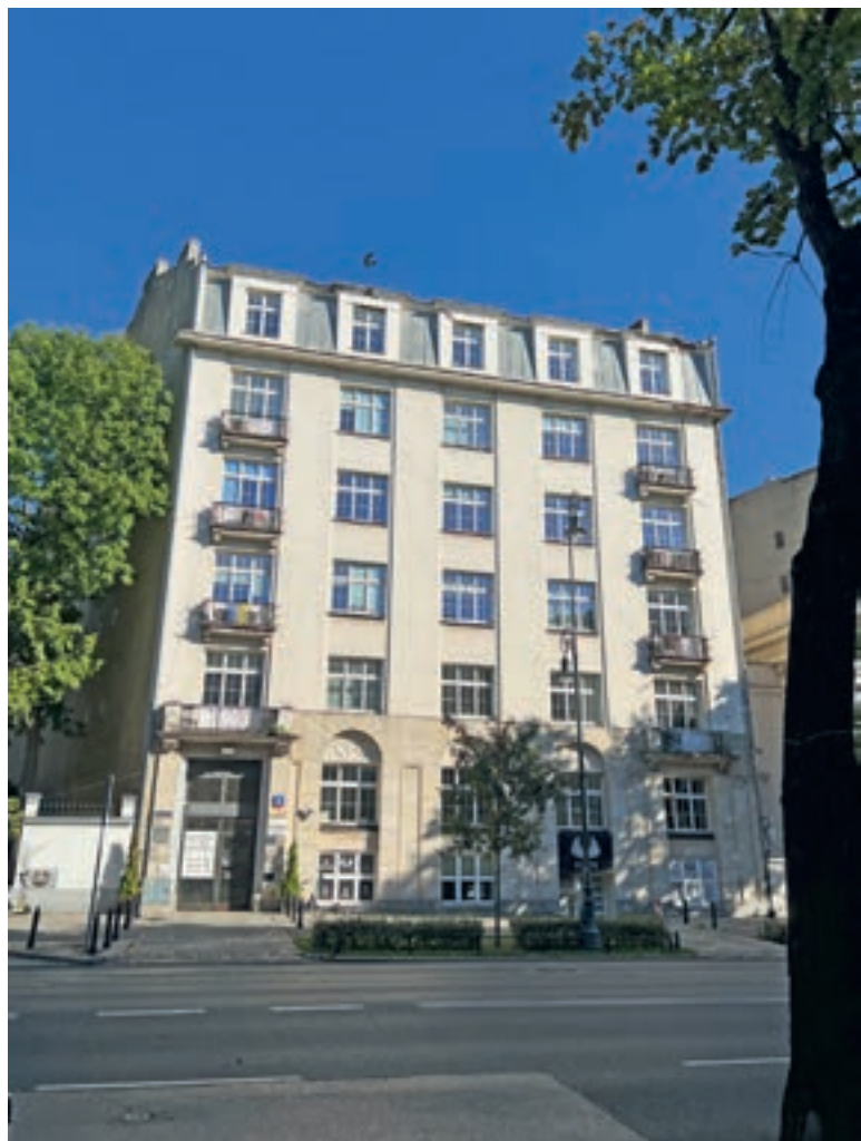
Dom przy al. Szucha 8. Miejsce akcji. Fot. M. Olczak, 2023 r.
