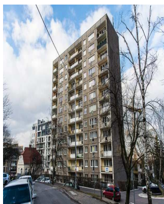
Zdjęcie nr 4. Budynek przy ul. Beniowskiego 24-24A
